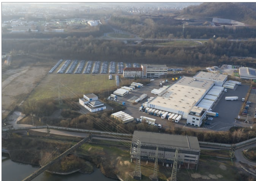
Blick von Osten über das bestehende Gewerbegebiet mit dem Plangebiet im Hintergrund
